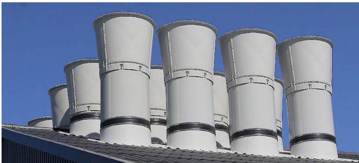
Figuur 6.5 Voorbeelden van stallen met geclusterde ventilatoren. Hier worden de oppervlakken van de emissiepunten niet gemiddeld maar samengenomen.
